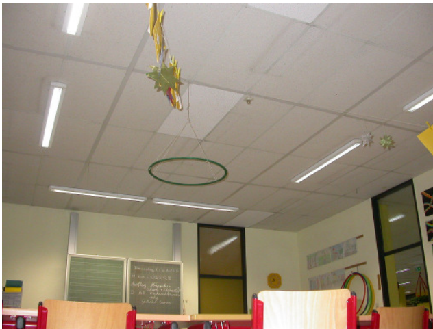
Bild 4: Klassen nach der Sanierung
