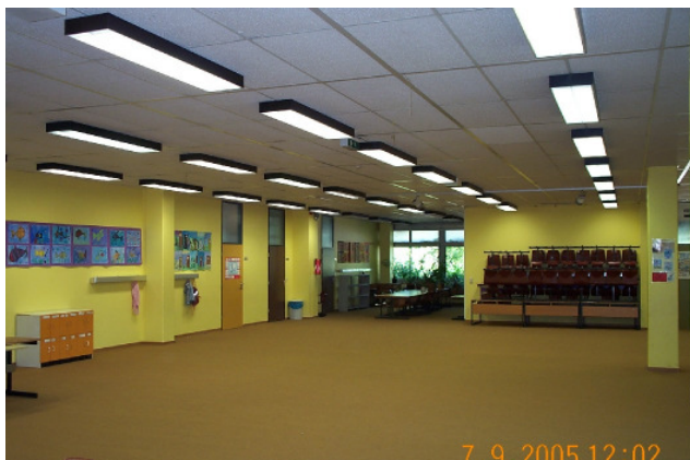
Bild 2: Typische Beleuchtungsanordnung in den Fluren
