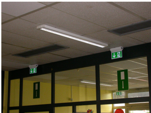
Bild 8: Fluchtwegbeleuchtung neu
