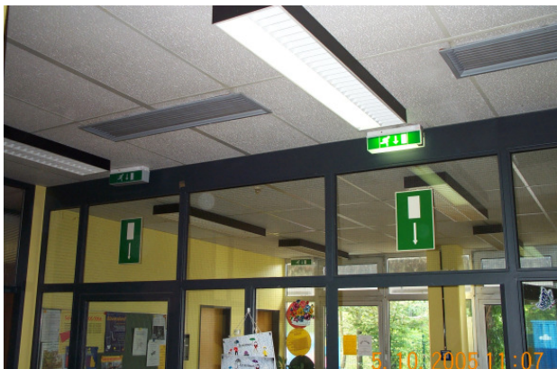
Bild 7: Fluchtwegbeleuchtung alt
