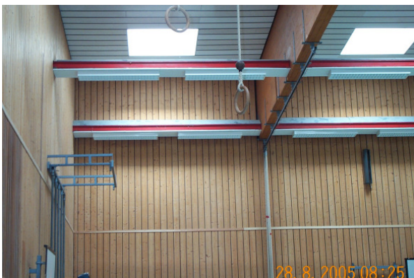
Bild 7: nach der Sanierung Wilhelm-Merton-Schule
