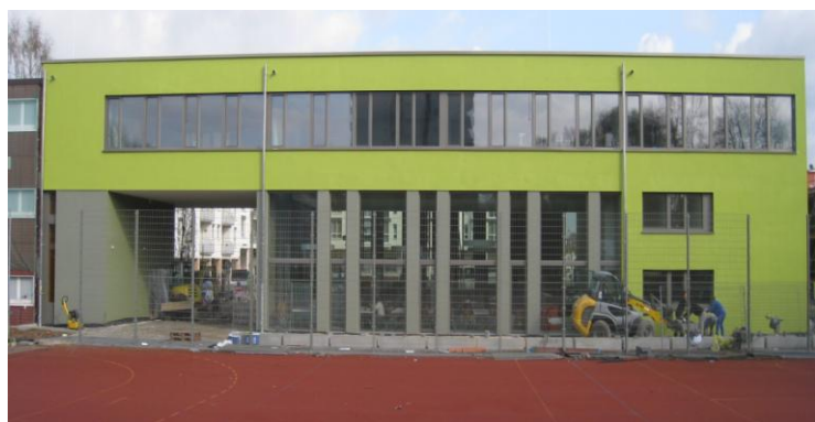
Abb.2: Neubau „Cafeteria“ mit Mensa im EG , Klassen im OG
